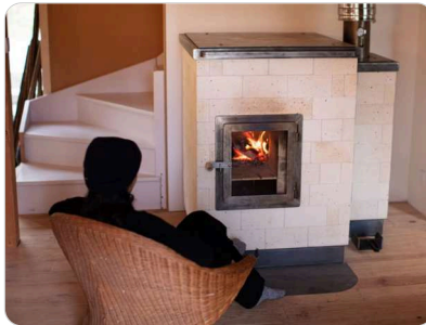
Fig. 22. – Poêle de masse uzume B14 v4 – foyer batchblock en béton réfractaire maçonné – source : uzume.fr
