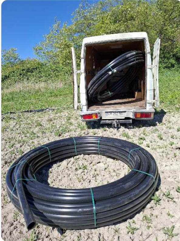
Fig. 9. – Couronnes DN63 avant déroulage
