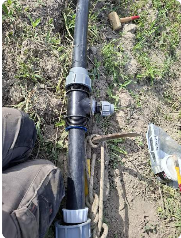
Fig. 14. - Té DN63 emboîté — vue rapprochée
