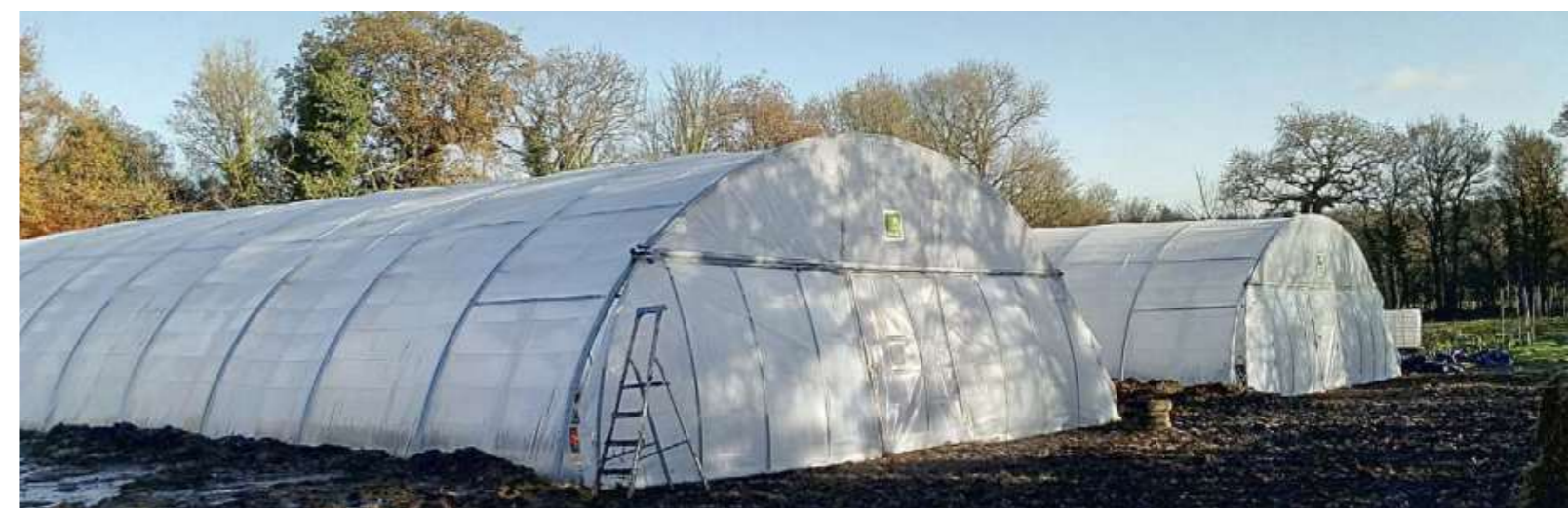
Montage des serres au Pont Capitaine
