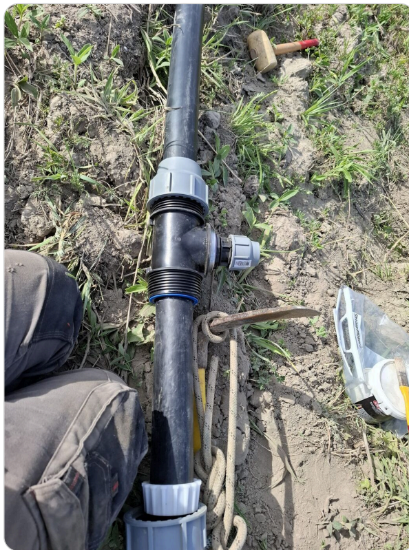
Fig. 14. – Té DN63 emboîté — vue rapprochée
