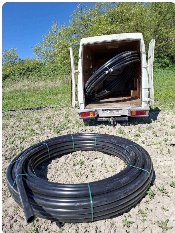
Fig. 9. - Couronnes DN63 avant déroulage
