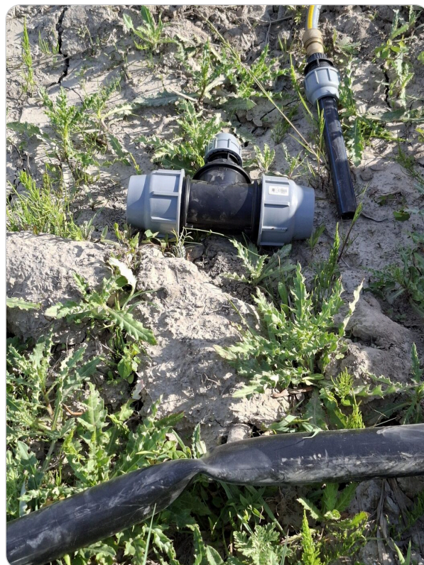
Fig. 16. – Le même té avant mise en place — la dérivation reçoit la rampe DN32
