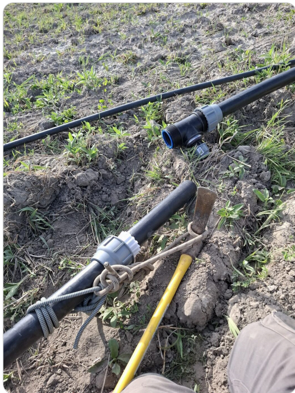
Fig. 13. – Blocage de la canalisation pour emboîtement du té
